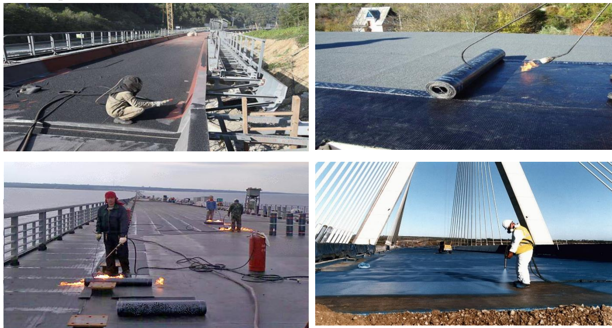
3-rasm. Ko'prik polotnosida gidroizolyatsiyani yotqizilish jarayonlari
