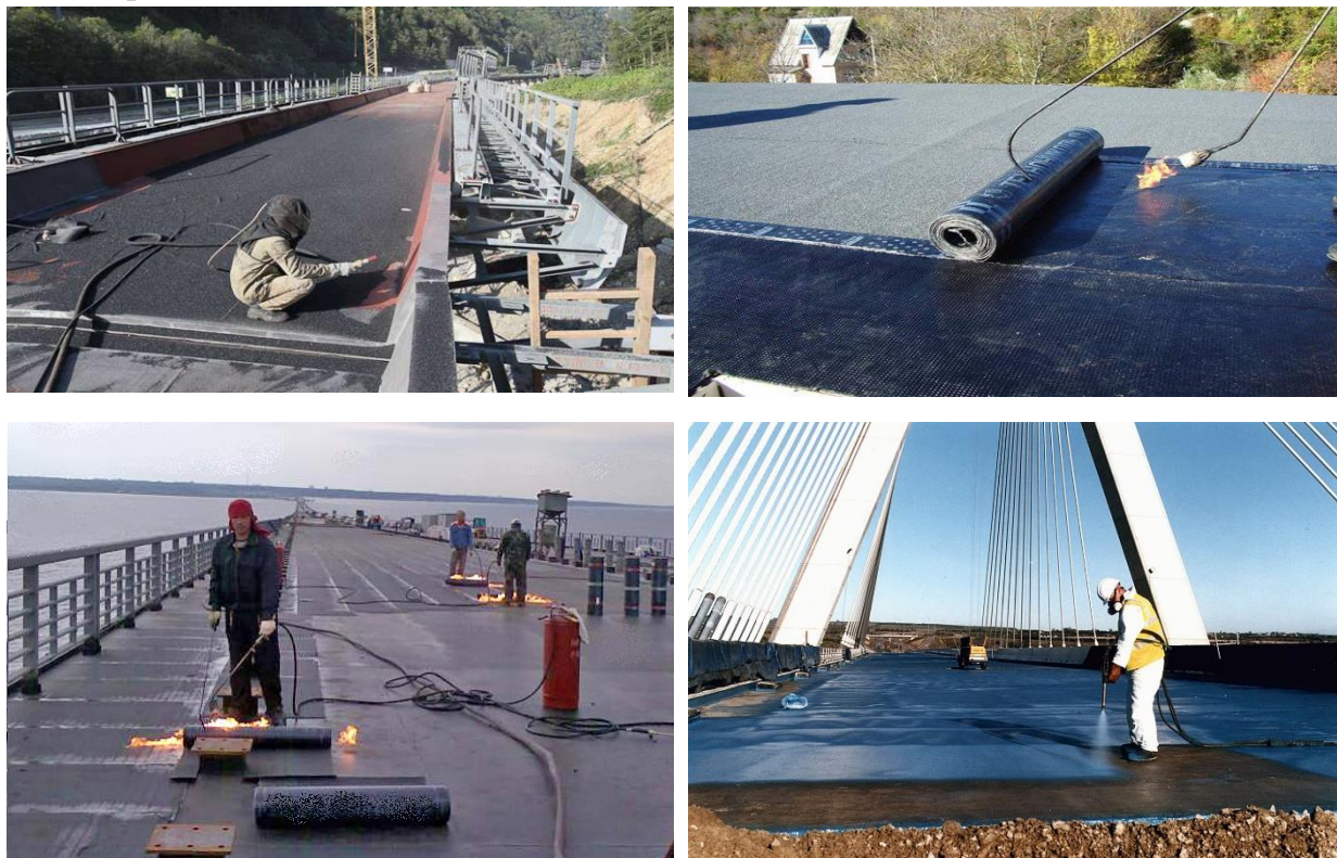
3-rasm. Ko‘prik polotnosida gidroizolyatsiyani yotqizilish jarayonlari
