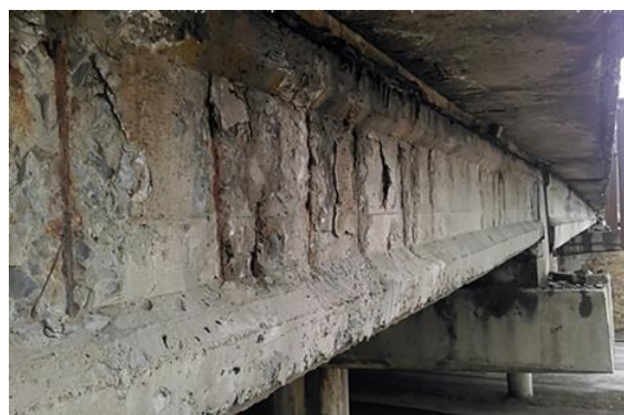
1-rasm. Temirbeton ko'prik konstruktiv elementlarining yemirilishi
