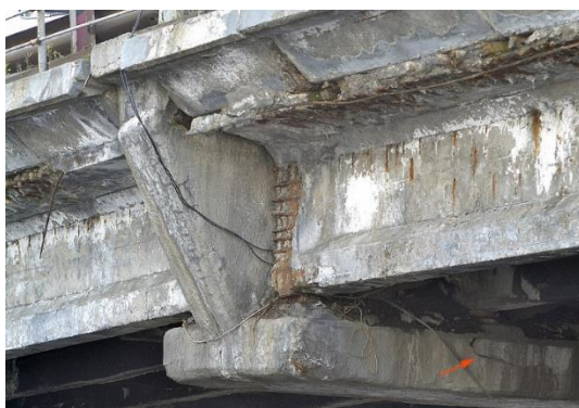
1-rasm. Temirbeton ko'prik konstruktiv elementlarining yemirilishi
